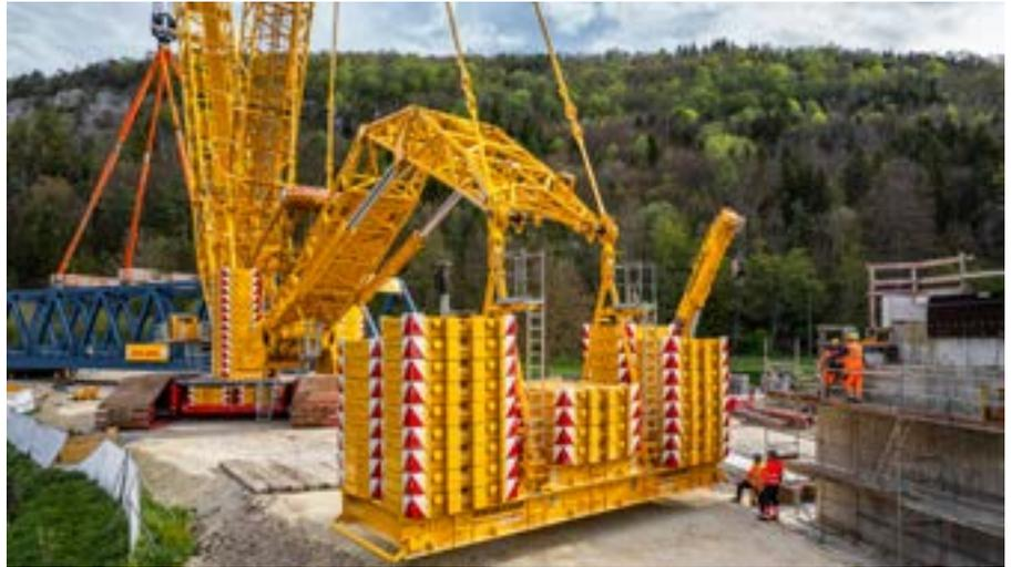
Le site, situé directement au bord de la rivière, avait été minutieusement préparé en amont de l'intervention. Des fondations spéciales et une dalle en béton ont permis d'assurer une stabilité suffisante sous l'aire de grutage. « Avec la grue et la charge suspendue, le sous-sol devait tout de même supporter un poids total d'environ 1 780 tonnes », explique Marco Wilhelm. Les supports de chenilles extra larges de 2,40 mètres ont permis une répartition optimale de la pression sur la surface.
