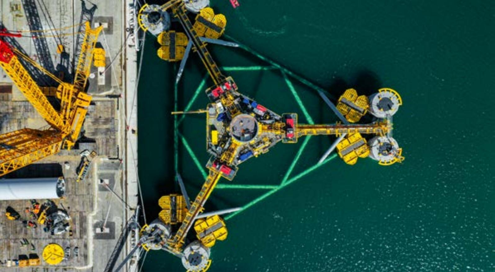
Les éoliennes flottantes peuvent être ancrées dans le fond marin à l'aide de câbles d'acier dans des zones où la profondeur de l'eau peut atteindre les 300 mètres.
