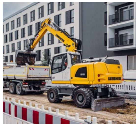
A 918 Litronic при выполнении земляных работ в Регенсбург (Германия)
