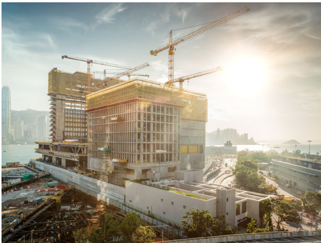
На службе у культуры и образования: верхнеповоротные краны на строительстве музея M+ в Гонконге
