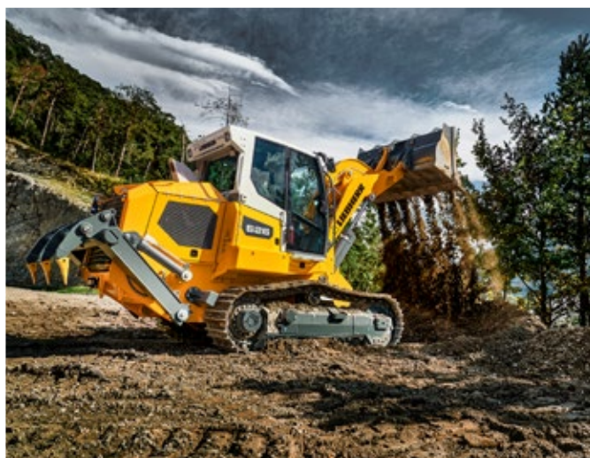
Гусеничный погрузчик LR 626 G8.0 осуществляет подготовку территории к застройке
