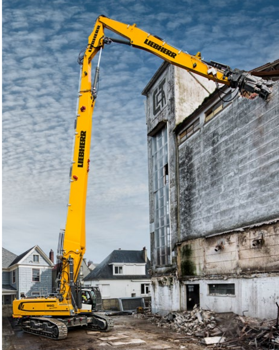
Экскаватор-разрушитель R 960 в ходе демонтажа здания в Фреване, Франция
