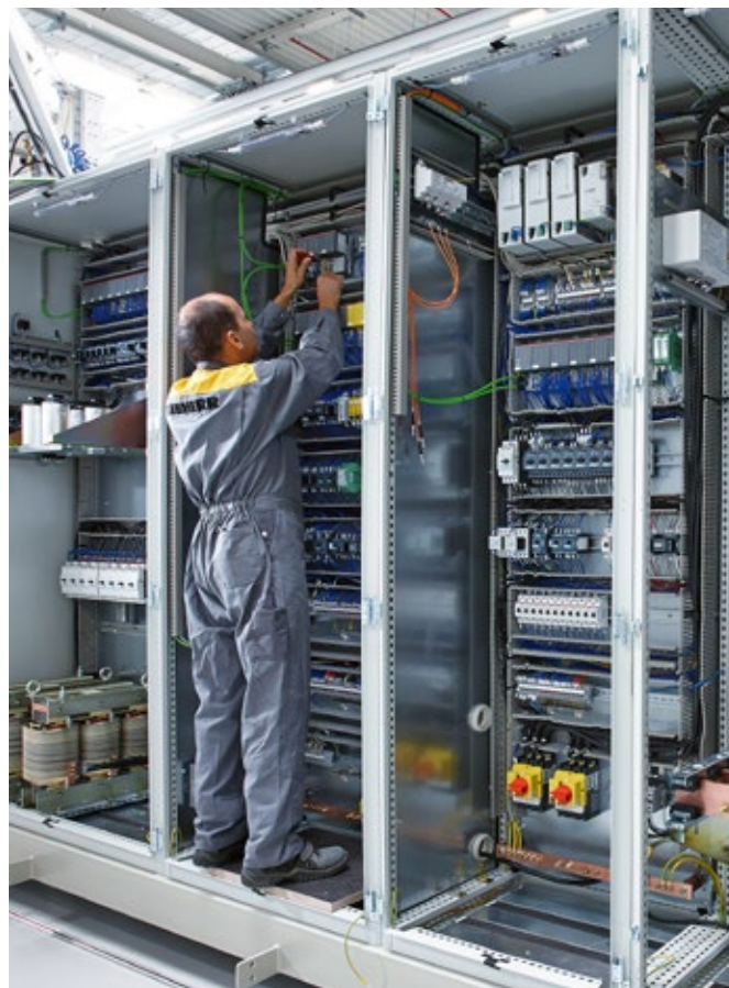
Монтаж шкафов управления для контейнерных кранов
