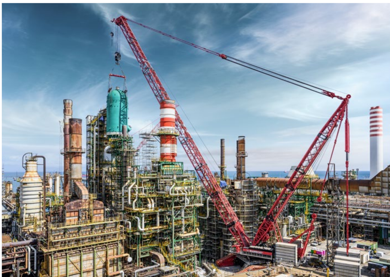
LR 13000, самый большой гусеничный кран Liebherr на строительстве нефтехимического предприятия в Италии
