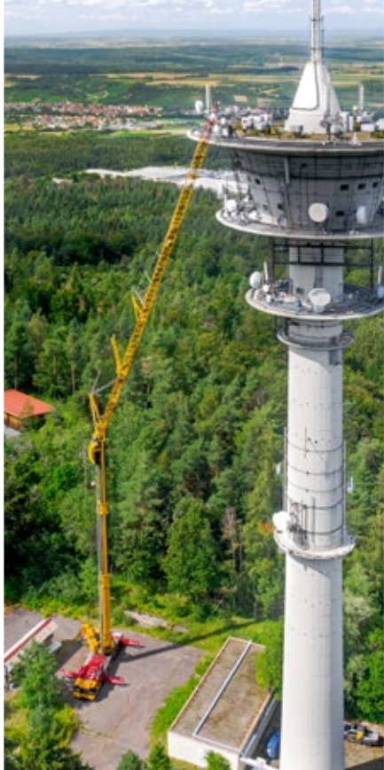
МК 140 в режиме поворотного крана на работах по замене системы антенн телебашни
