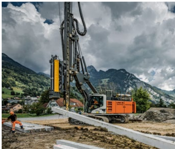
LRB 18 на забивке бетонных свай на озере Валензее (Швейцария)
