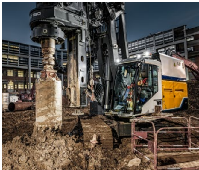
Аккумуляторная буровая установка LB 16 unplugged на строительной площадке в Париже
