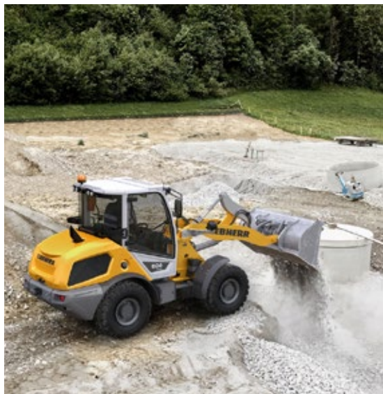
L 506 на строительной площадке
