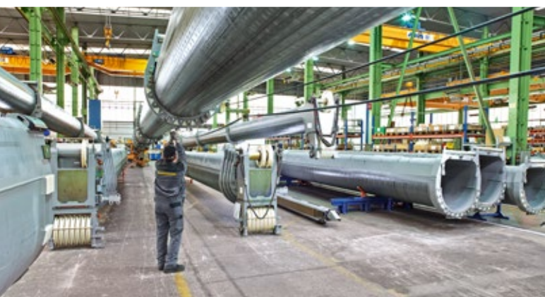
Монтаж телескопических стрел
