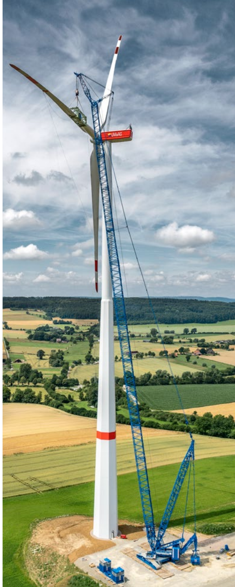
LR 1700-1.0 на строительстве ветрогенератора в Германии
