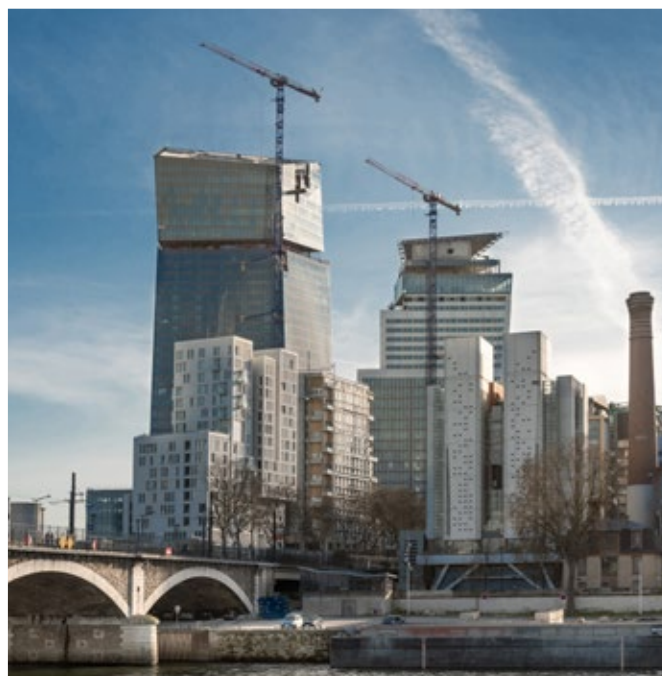
Башни-близнецы: краны EC-B на строительстве Tours Duo в Париже (Франция)
