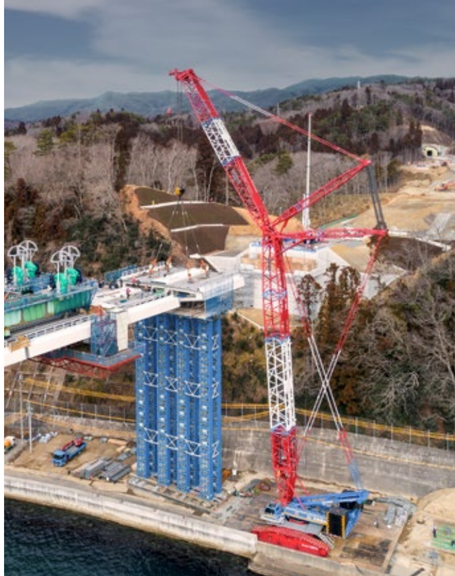
LR 1750/2 на строительстве моста в Японии
