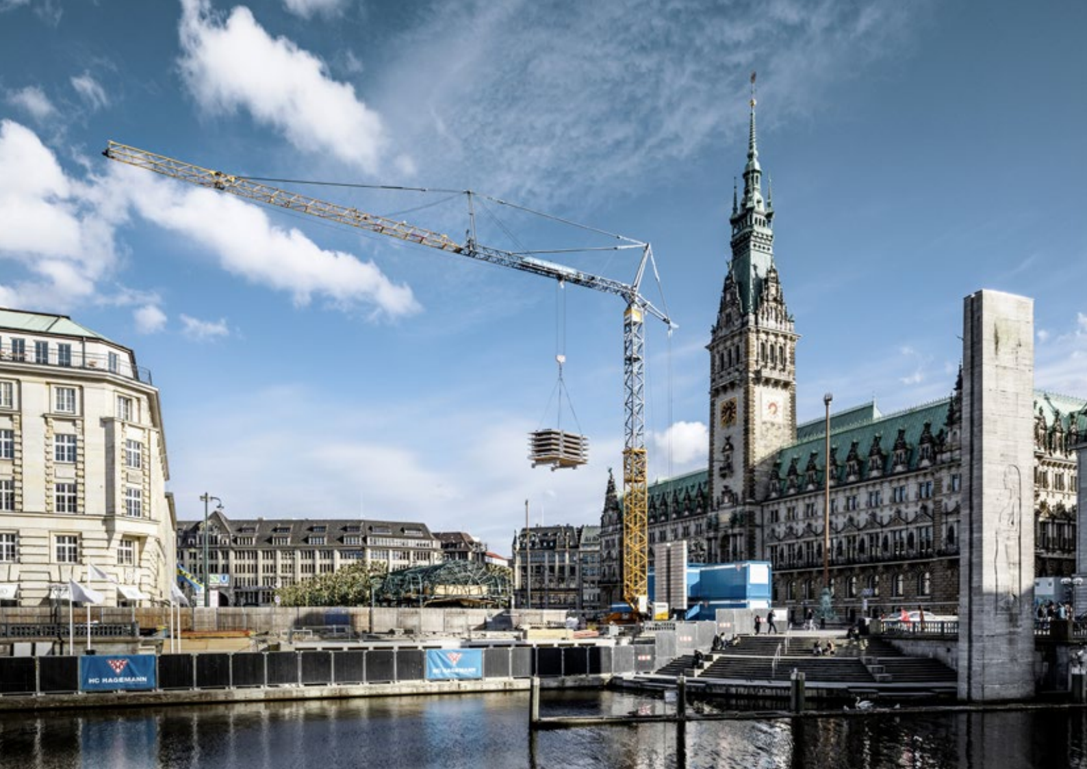
Кран оперативного применения 81 K.1 повышенной грузоподъёмности на реставрации ратуши в Гамбурге (Германия)
