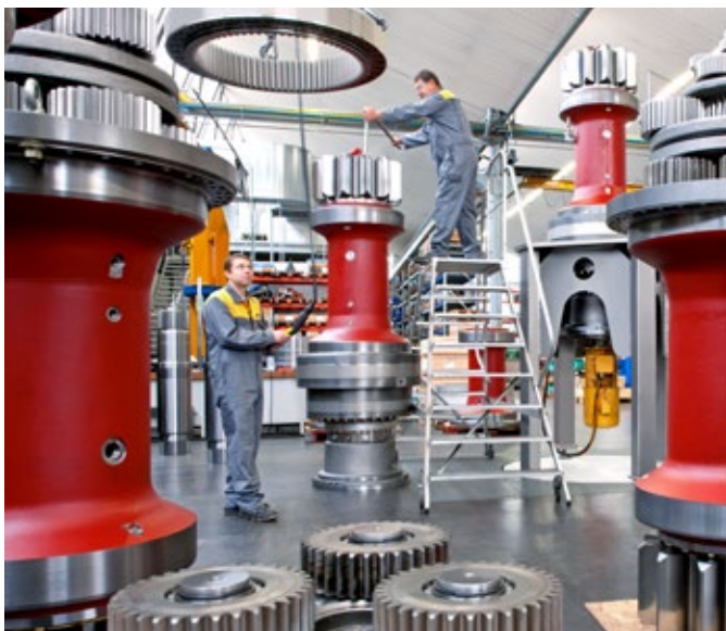
Монтаж приводов вращения типа DAT 1000
