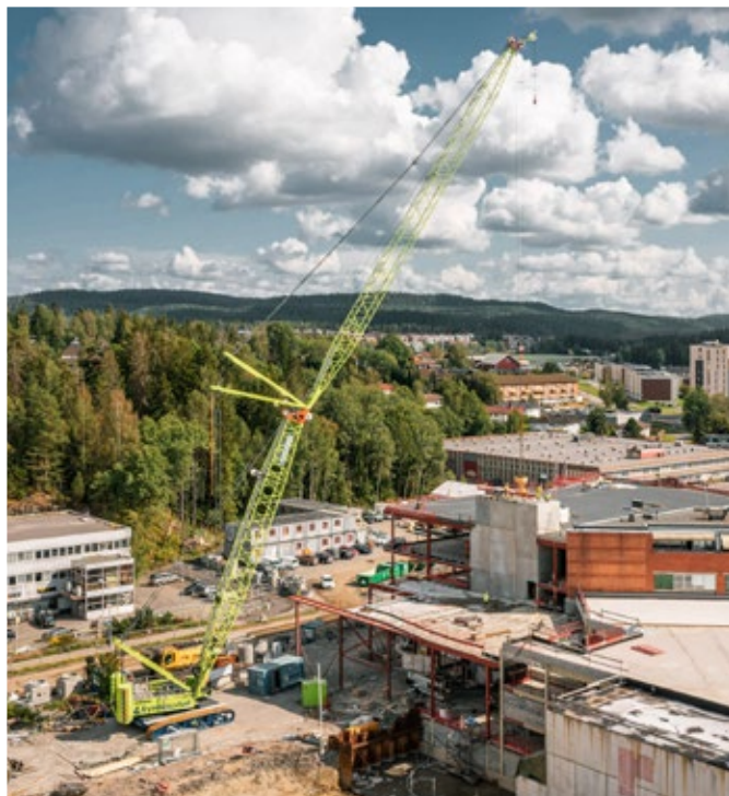
Аккумуляторный гусеничный кран LR 1250.1 unplugged на монтажных работах в Осло (Норвегия)
