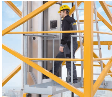
Innenliegender Zustieg über das Podest
