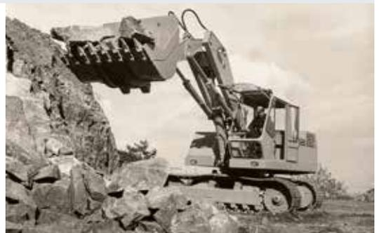
Der in Colmar produzierte Raupenbagger RT 1000 bringt 20 Tonnen Einsatzgewicht auf die Waage.
